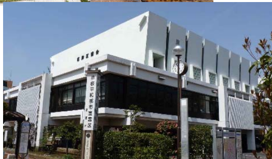
昭和 37 年に竣工し、建築後 48 年が経過した区役所本館(上)と議会棟(下)
