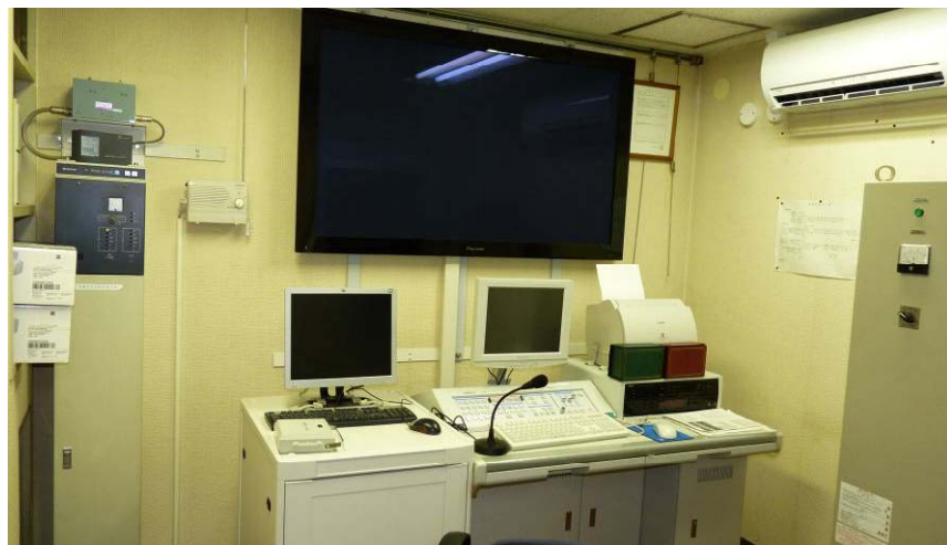
狭い防災設備室
