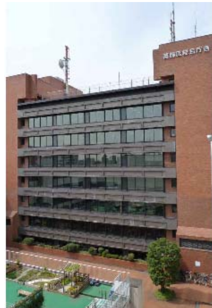
昭和 53 年に竣工し、建築後 32 年経過した区役所新館
