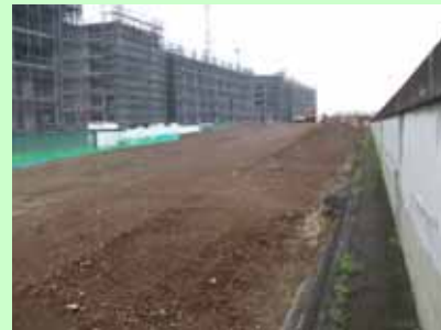
現地写真（綾瀬川スーパー堤防工事）
