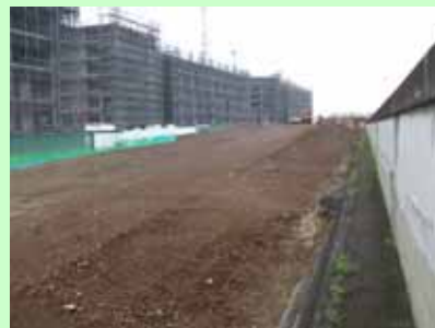
現地写真（綾瀬川スーパー堤防工事）
