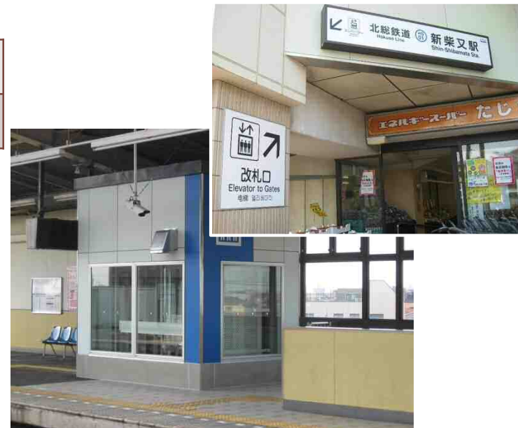
▲ 新柴又駅に設置されたエレベーター 14
