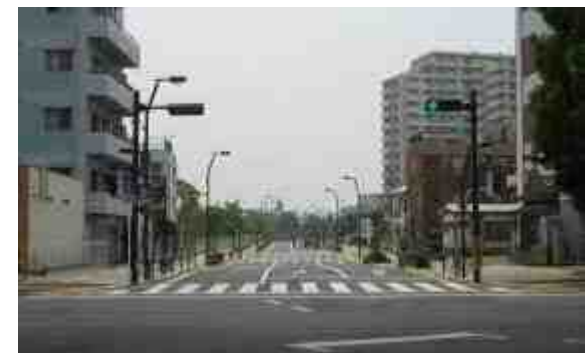
▲ 都市計画道路 補助330号線 (新小岩):整備後
