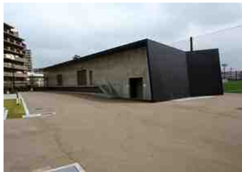
▲ 葛飾にいじゅくみらい公園 災害備蓄倉庫 11
