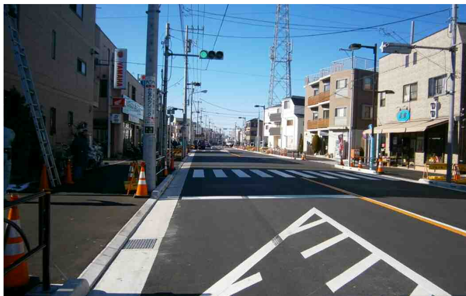
▲ 都市計画道路 補助264号線(細田東):整備中
