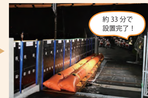
止水板の後ろに水のうを設置して、完了です
