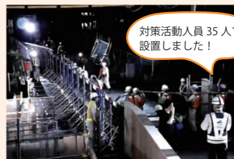
高さ1.8mの止水板を設置します
