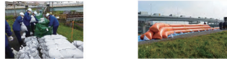
荒川左岸(葛飾区側)土のう設置状況
